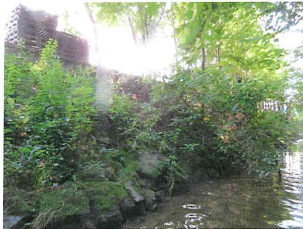
odstranění veškerého porostu z opěrných dlažeb
