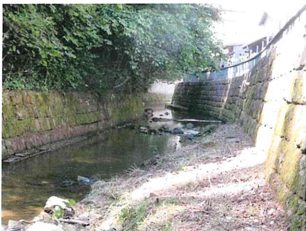
výřez veškerého porostu na zdi v šíři cca 1m
