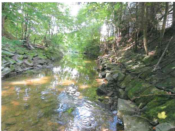
odstranění veškerého porostu z opěrných dlažeb
